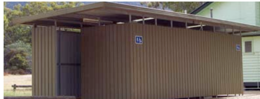
Accessible public toilet
